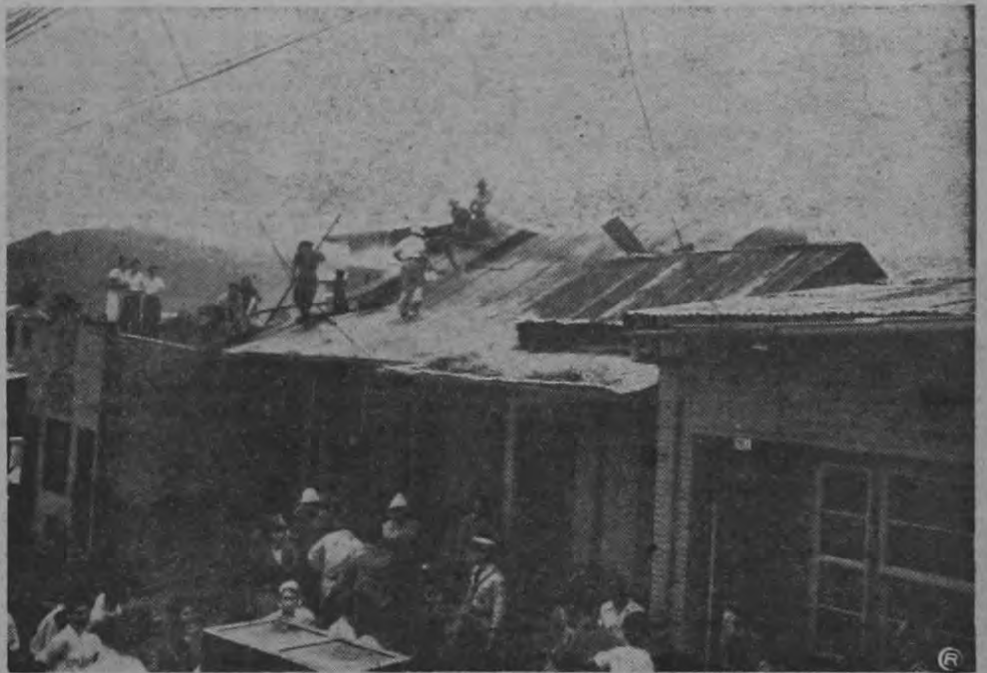
Bomberos y particulares aparecen en la gráfica cuando hacían lo imposible por combatir el incendio que ayer se declaró en casas de Barrio Keith, situadas exactamente al sur de la Iglesia de los Angeles. Tres residencias sufrieron daños de consideración, estimándose las pérdidas en ₡ 25.000.00 (Foto Arévalo, para LA REPUBLICA). (Ver información en página 10)
